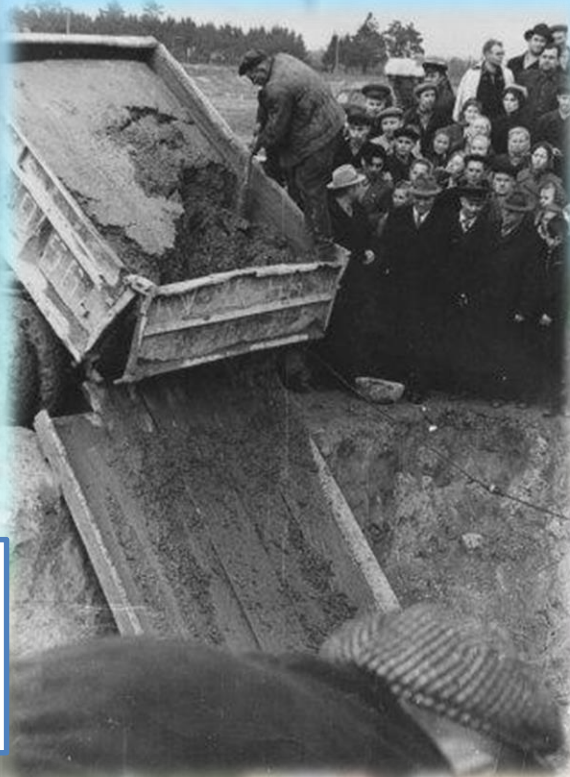
Первые тонны бетона под основание колонны главного корпуса товарной пряжи Барановичского хлопчатобумажного комбината. 1961 год. УК «Барановичский краеведческий музей». КР_003927
