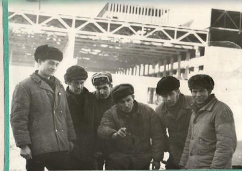
На строительстве комбината железобетонных конструкций (1966)
