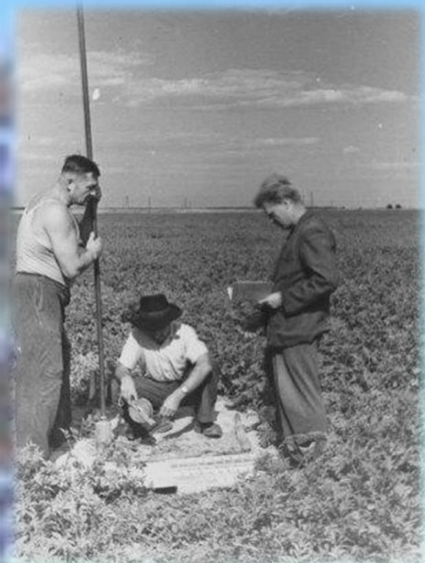
Геолого-разведочные работы на площадке под строительство Барановичского хлопчатобумажного комбината. 1959 год. УК «Барановичский краеведческий музей». КР_003684_1
