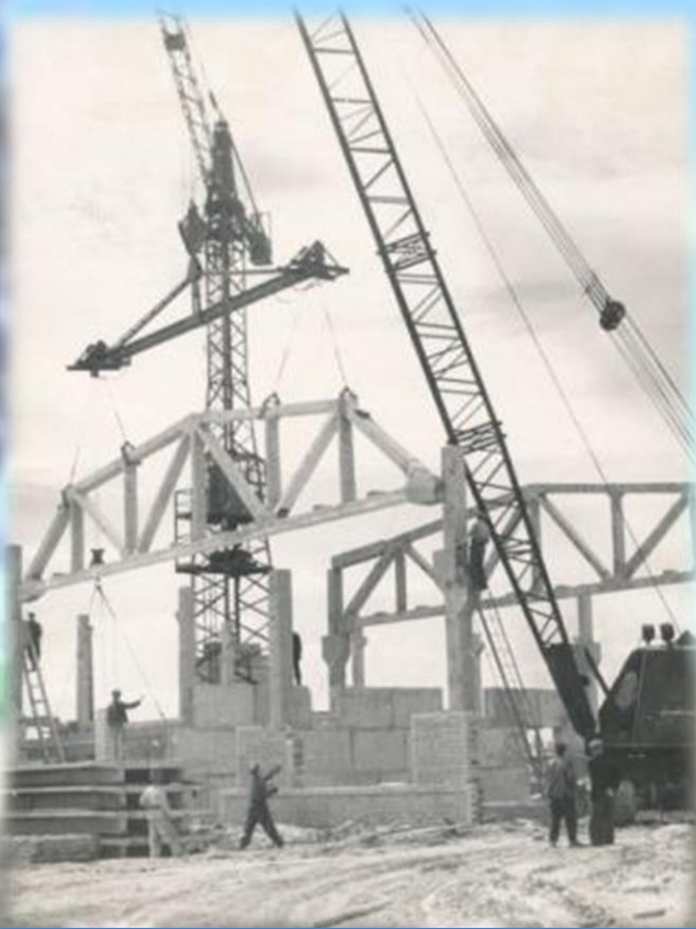
Начало строительства Барановичского хлопчатобумажного комбината. 1961 год ЗГАБар. Ф. 138. Оп. 5. Д. 12. Л. 2
