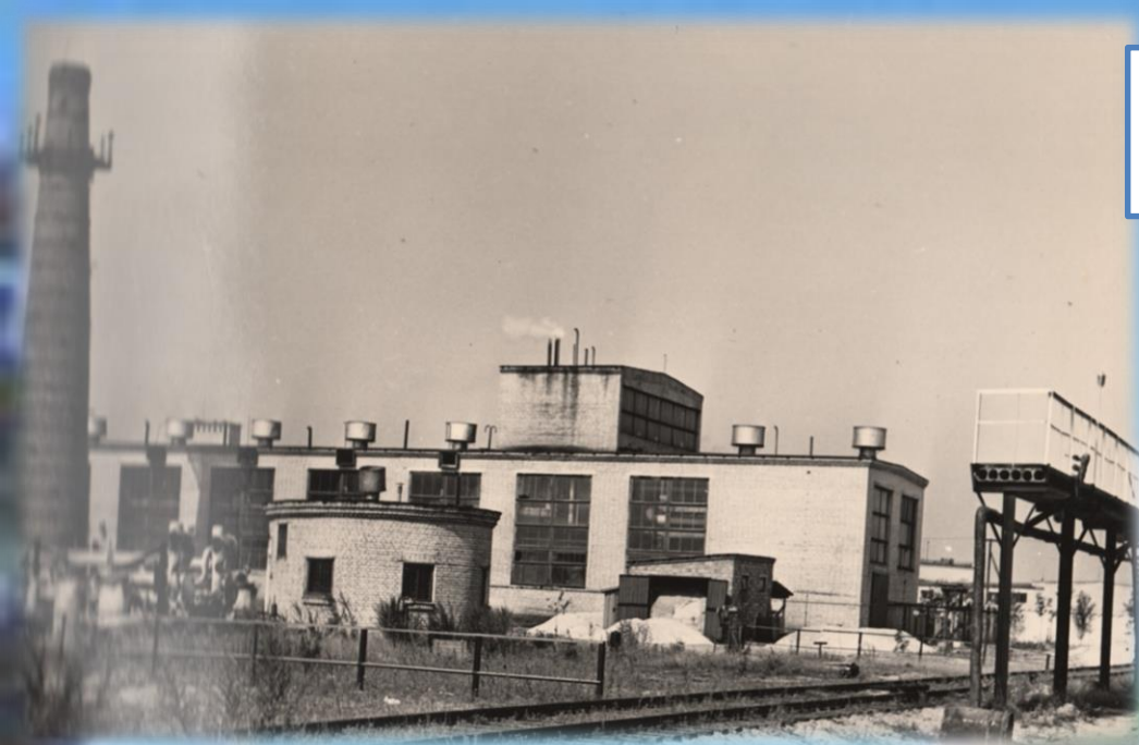
Здание котельной завода торгового машиностроения Ф. 138. Оп. 5. Д. 9. Л. 4
