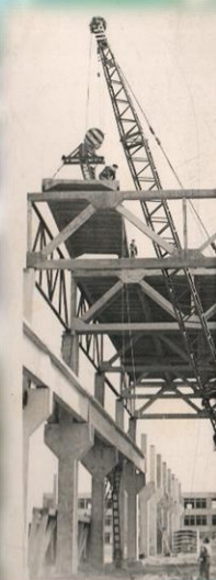
На строительстве арматурного цеха комбината железобетонных конструкций (1965)
